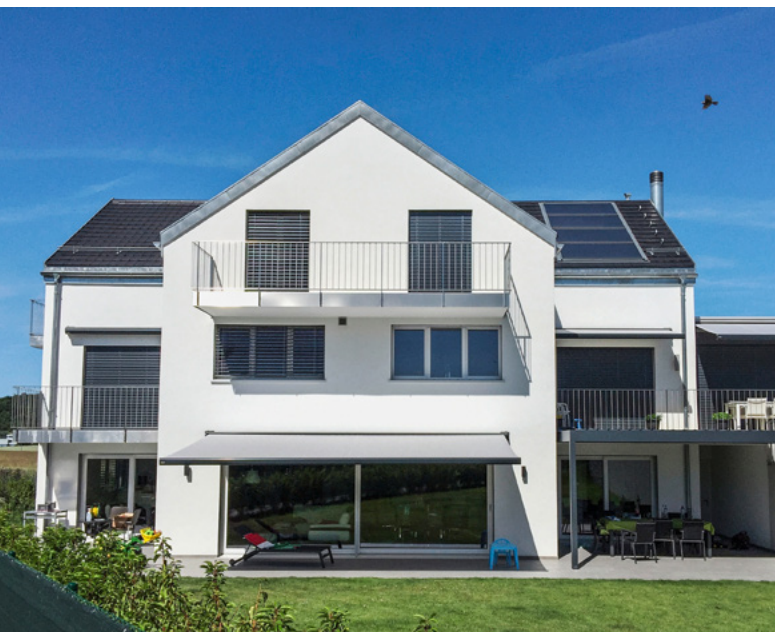
Ein Haus, zwei Wohnungen und zwei Familien mit unterschiedlichen Ansprüchen. Quelle: F. Matthey
